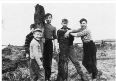
Eichenpfähle dienten als Fundament für das ehemalige Wasserschloß.
