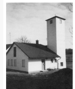
Der Schlauchtrockenturm des Feuerwehr-Gerätehauses mit neu errichtetem Anbau.
